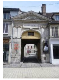
Fig. 8 : Porche d'entrée du château
