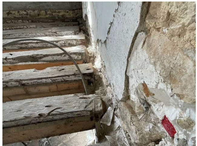
Photographies des planchers dégradés
