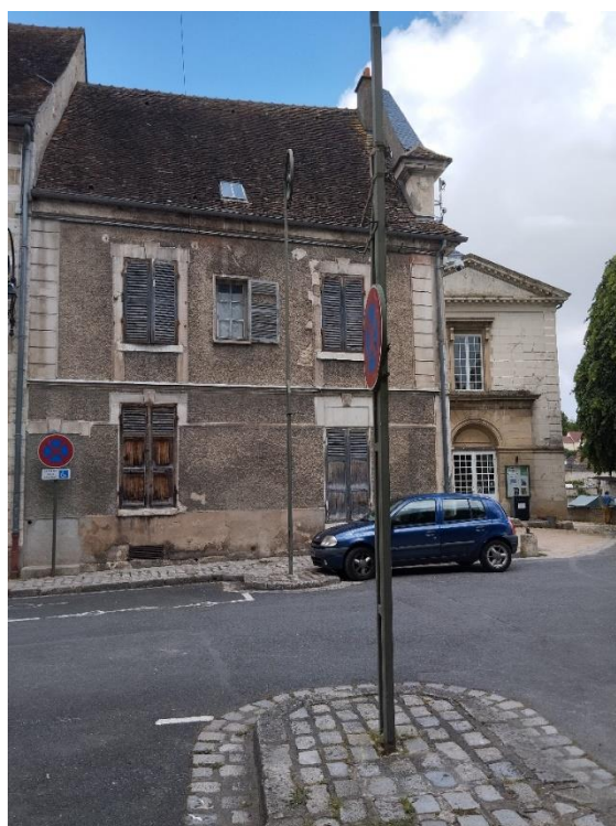
Figure 8 - Bâtiment accolé à l'ancienne mairie, exclu de la fiche n°8 (photo : commune de Nemours)
