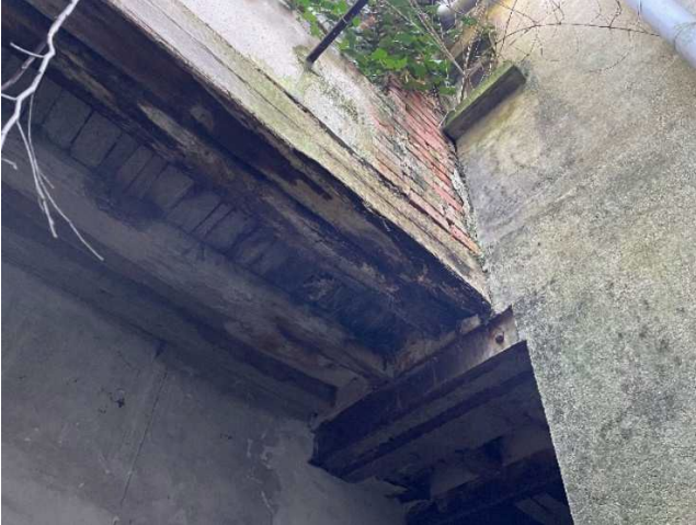
Photographies de poutres pourries non protégées
