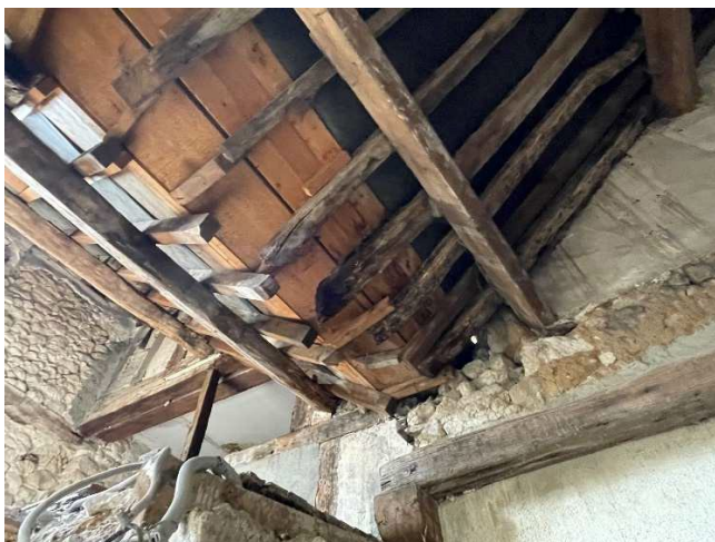
Photographies des charpentes ne respectant pas les règles de construction ou sans appuis
