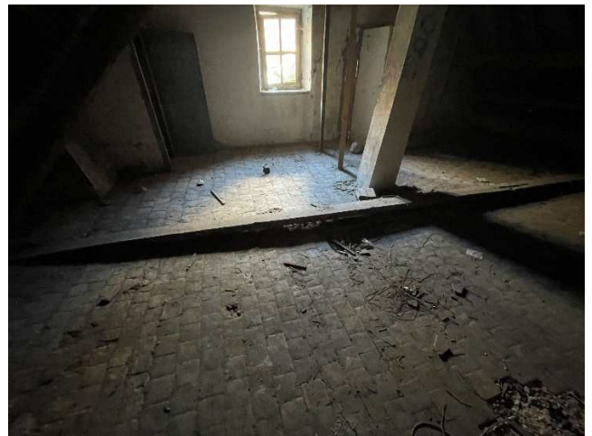
Photographies en combles au droit d'un entrait montrant une flèche importante
