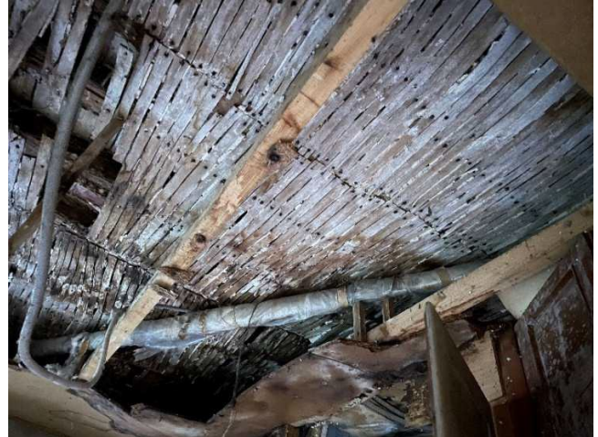
Photographies de poutres pourries non protégées
