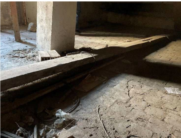
Photographies en combles au droit d'un entrait montrant une flèche importante
