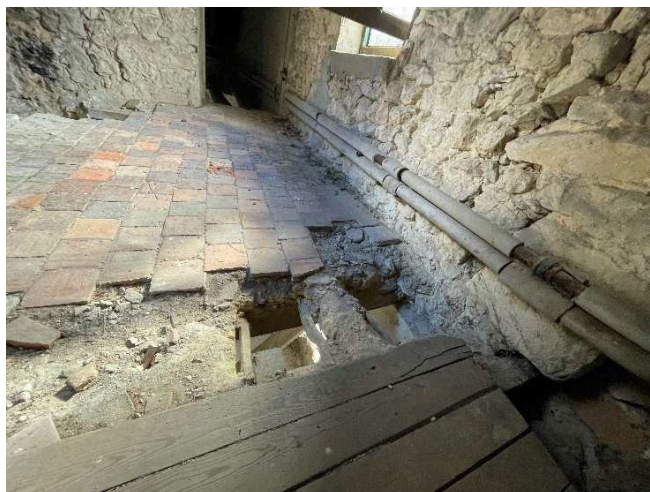
Photographies des planchers dégradés
