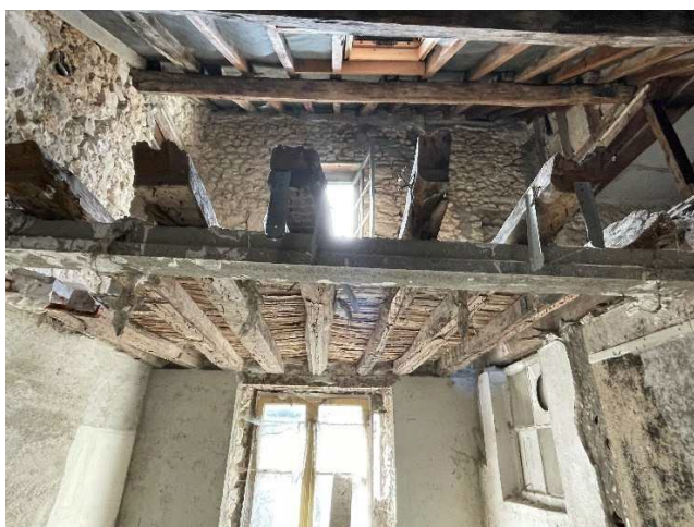
Photographies des planchers dégradés
