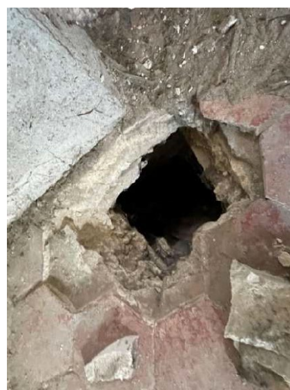
Photographies des sols en place présentant des tassements importants et des désordres
