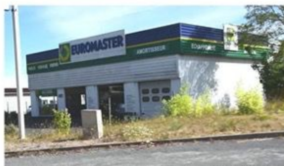
Taille des lettres, mais également dépassement de la limite du mur illégal au titre du R.N.P. (article R.581-60)
