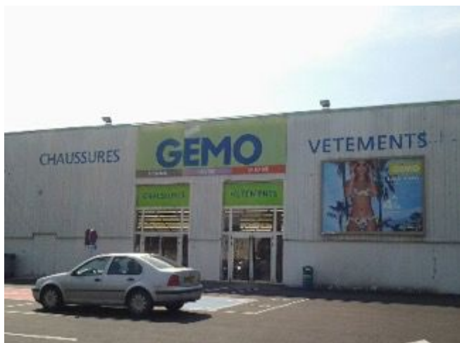
Enseigne parallèle au mur sur panneau de fond, Nemours, Septembre 2019
