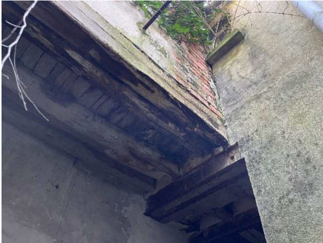
Photographies de poutres pourries non protégées
