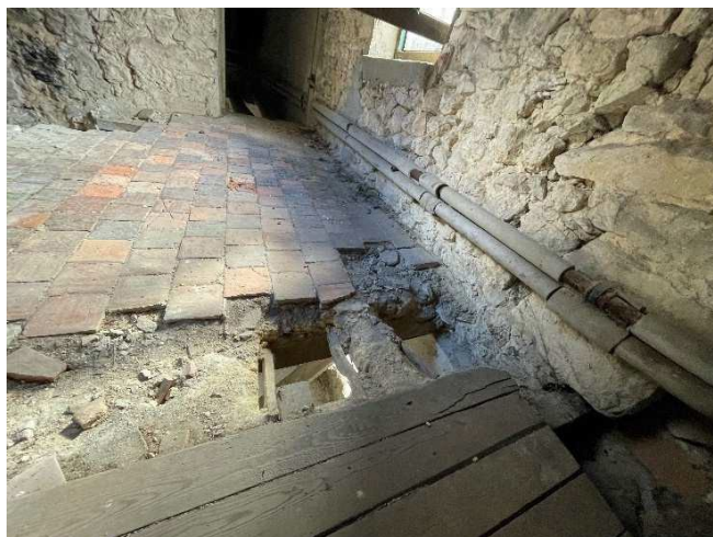
Photographies des planchers dégradés
