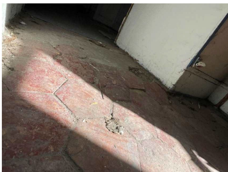
Photographies des sols en place présentant des tassements importants et des desormes
