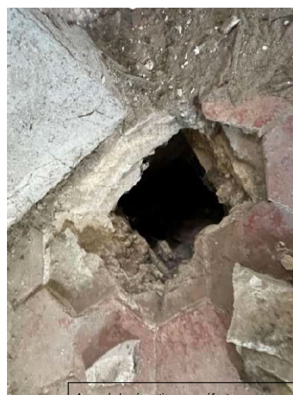
Photographies des sols en place présentant des tassements importants et des desormes
