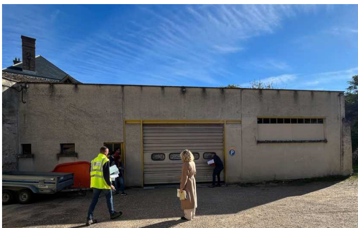
Photographie de la façade sur cour du hangar du lot 2 non adapté au projet
