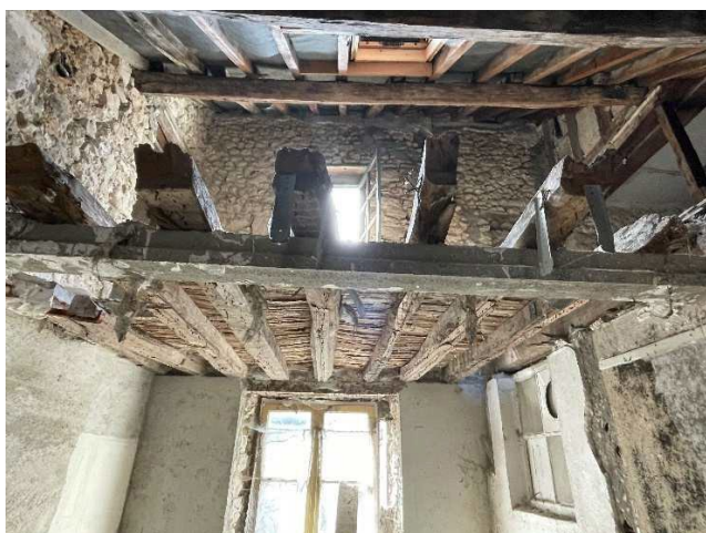
Photographies des planchers dégradés
