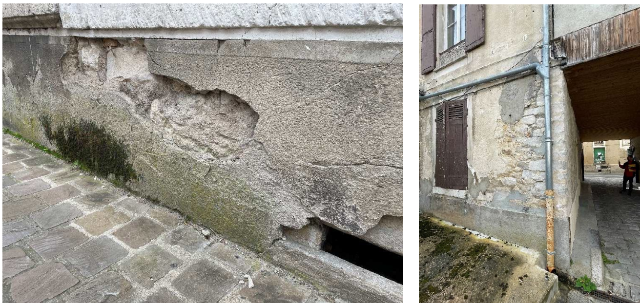
Photographies d'enduits ciment en façades réalisés sur la maçonnerie en pierres
