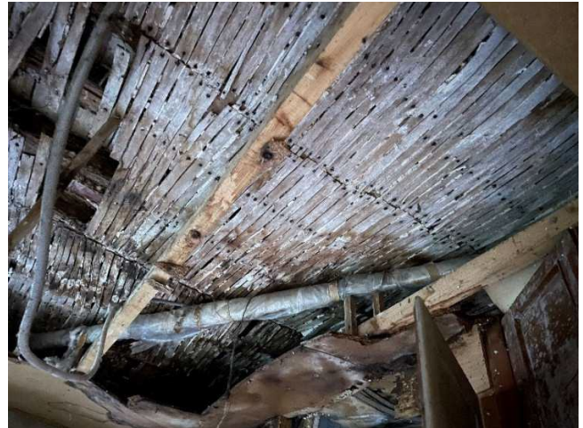
Photographies de poutres pourries non protégées
