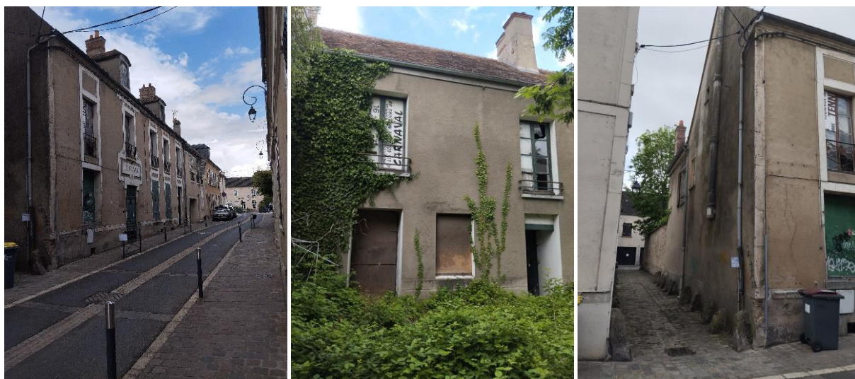
Figure 12 - Vues sur le bâtiment dit du Foyer Dumée, dont l'état de la structure est compromis (photos : commune de Nemours)
