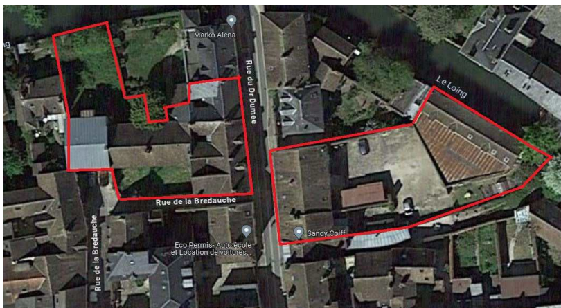
Vue satellite des bâtiments concernés par le projet
