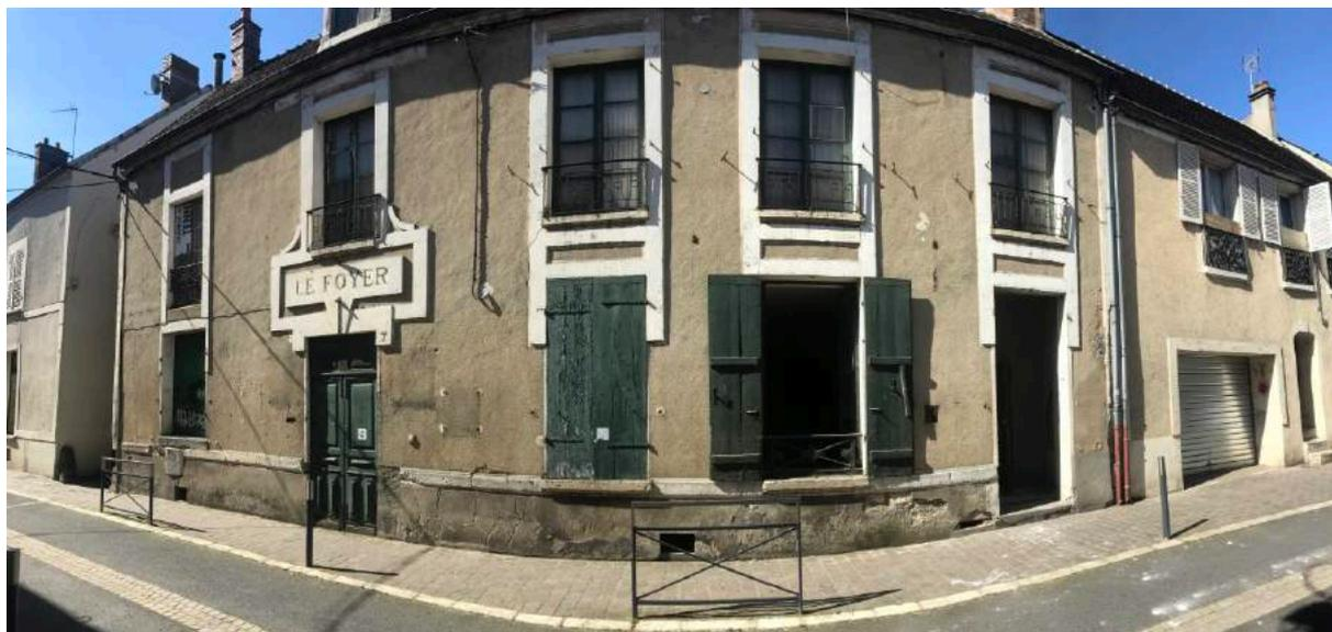
Les ensembles menuisier sont pourvus de moulures ajoutées en plâtre d'esthétique simple et régulier. L'entrée principale donnant accès à un porche est quant à elle un peu plus travaillée marquant l'accès principale du bâtiment. L'accès secondaire est quant à lui travaillé de façon similaire aux fenêtres permettant de hiérarchiser les différents accès. Il est possible que cet accès fût initialement une simple fenêtre puis modifié pour les besoins des utilisateurs.
