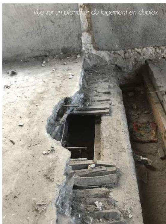
L'ensemble des structures des planchers souffrent d'une vétusté avérée. Certains planchers sont absents, partiellement vidés et également avec des devers importants.
