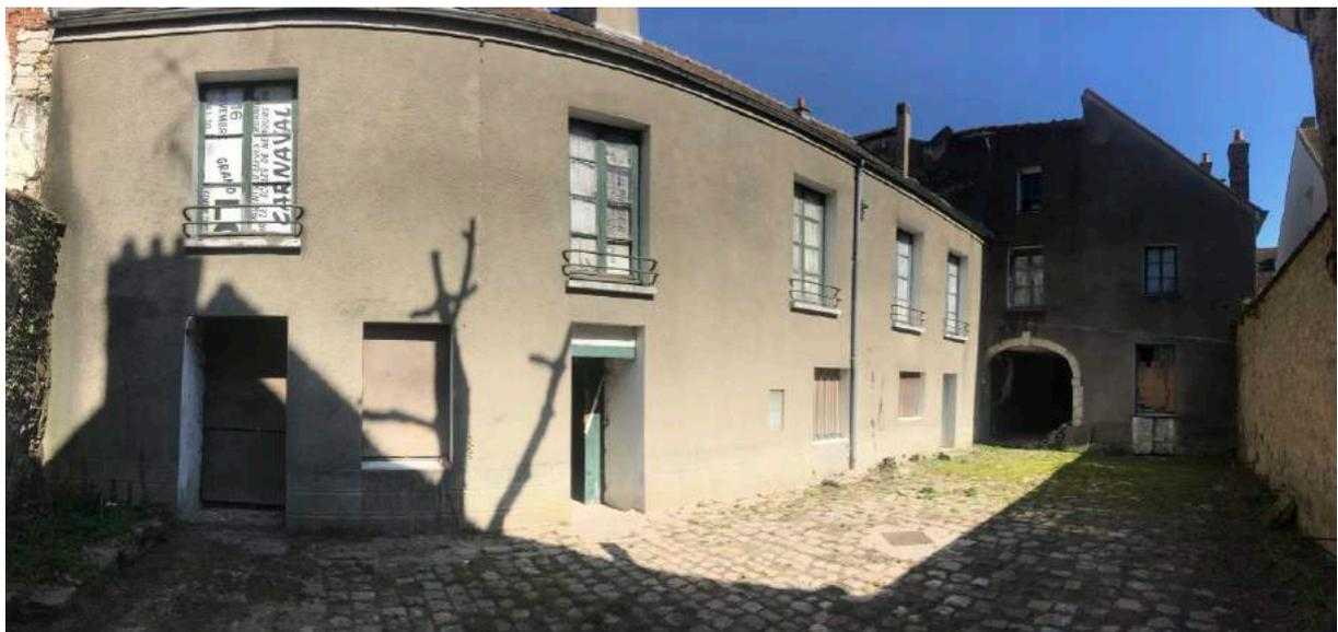
Ce bâtiment est composé de deux niveaux et de combles coiffé d'une couverture en tuiles plate petits moules à deux versant. De par son implantation, la façade sur cour est seulement percée d'ouvertures régulières de tailles et dispositions récentes. Le rez-de-chaussée accessible depuis la cour, offre de petits volumes bas de plafond certainement destinés en espaces de stockage. La façade couverte d'un enduit plein masque les structures en pierres visibles depuis l'intérieur.
