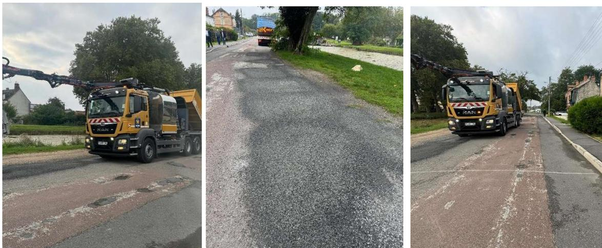
Cette machine intervient en plusieurs étapes : après un nettoyage, celle-ci utilise un chalumeau pour le ramollissement du sol, puis projette une émulsion de bitume et granulats et enfin compacte pour une finition optimale. Ces améliorations visent à renforcer la durabilité et l'étanchéité des routes pour un meilleur confort de circulation.
