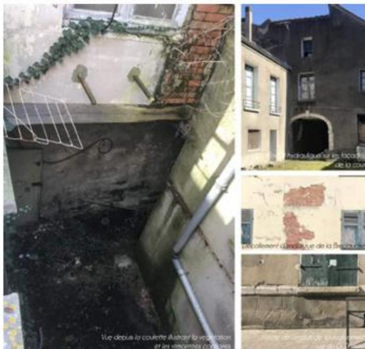
Les enduits intérieurs sont généralement ruinés liés à l'absence d'entretien et l'absence de ventilation des locaux. En effet, les enduits plâtre et chaux sont généralement fissurés, gonflés et décollés. Afin de pérenniser les intérieurs et selon les futurs aménagements il convient de mettre à nu l'ensemble des maçonneries avant restauration.
