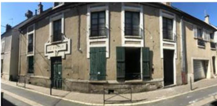
Les ensembles menuisier sont pourvus de moulures ajoutées en plâtre d'esthétique simple et régulier. L'entrée principale donnant accès à un porche est quant à elle un peu plus travaillée marquant l'accès principale du bâtiment. L'accès secondaire est quant à lui travaillé de façon similaire aux fenêtres permettant de hiérarchiser les différents accès. Il est possible que cet accès fut initialement une simple fenêtre puis modifié pour les besoins des utilisateurs.
