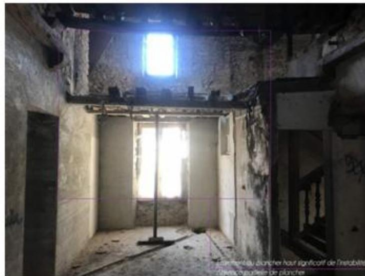
l'absence de plancher haut significatif de l'instabilité structurelle de plancher
