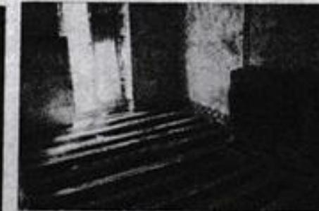
Les murs de pierres bétonnés lors d'anciennes rénovations empêchent de mesurer l'état réel de la structure.
