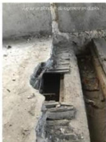
L'ensemble des structures des planchers souffrent d'une vétusté avérée. Certains planchers sont absents, partiellement vidés et également avec des dévers importants.
