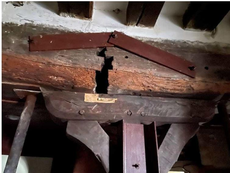
*Photographie d'une poutre principale cassée et étayée provisoirement*
