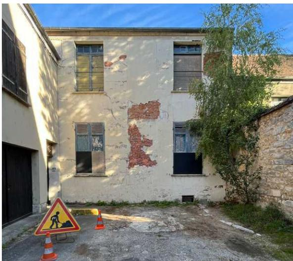
*Photographie de la façade arrière du lot 1 en mauvais état sur rue de la Bredauche*
