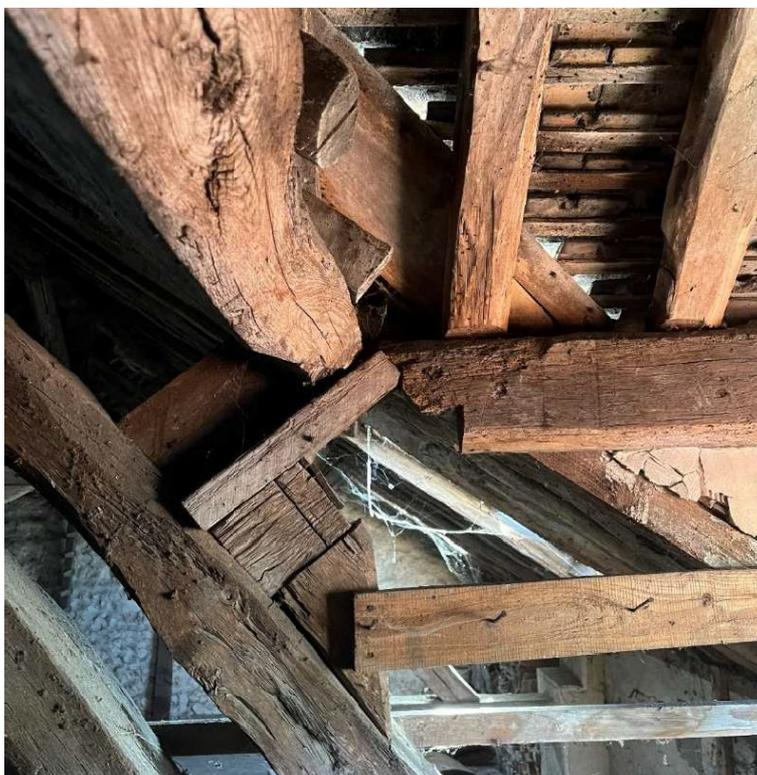
Photographie locale des charpentes ne respectant pas les règles de construction
