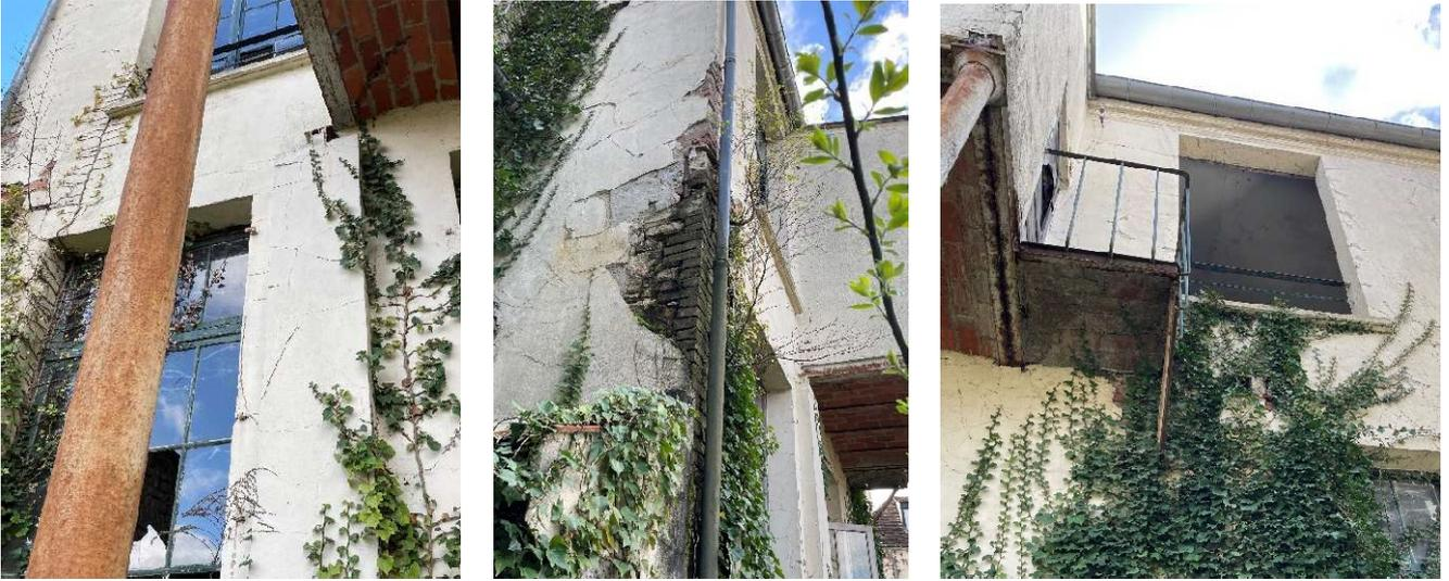
Photographies de murs fissurés en façade sur cour arrière du lot 02
