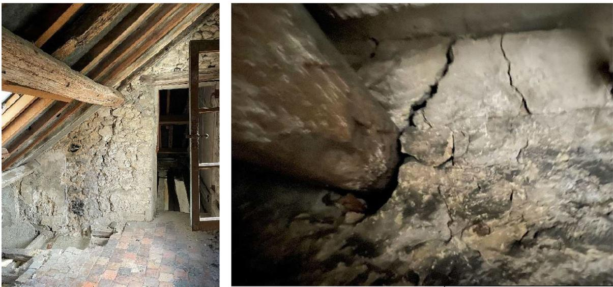
Photographies de fissures en intérieur de bâtiments au droit d'appuis de seuils en bois
