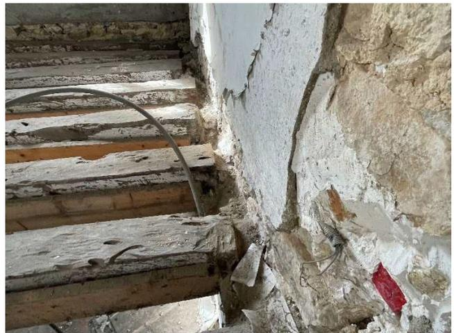
Photographies des planchers dégradés
