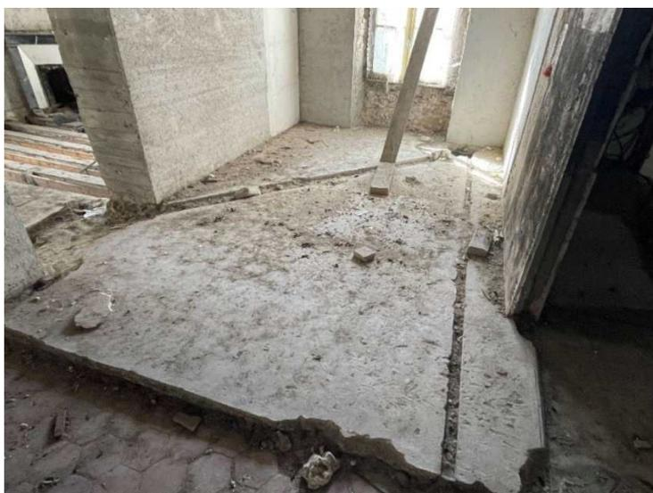
Photographies des sols en place en mauvais état
