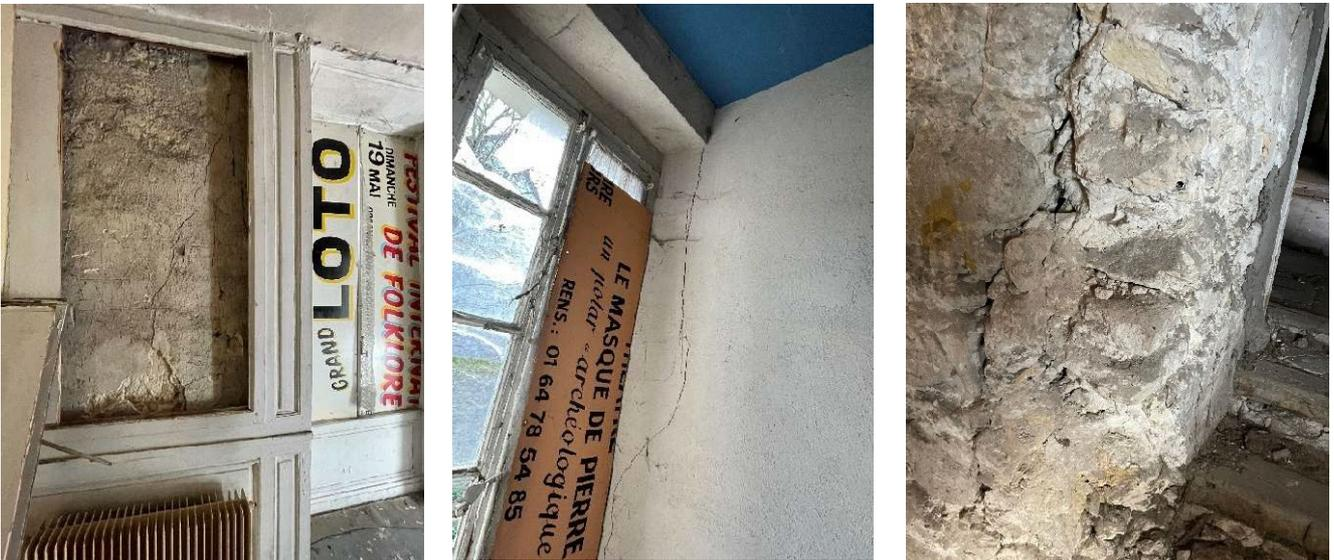
Photographies de murs fissurés en intérieur de bâtiments
