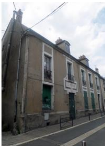
Site du Foyer rue Docteur Dumée
