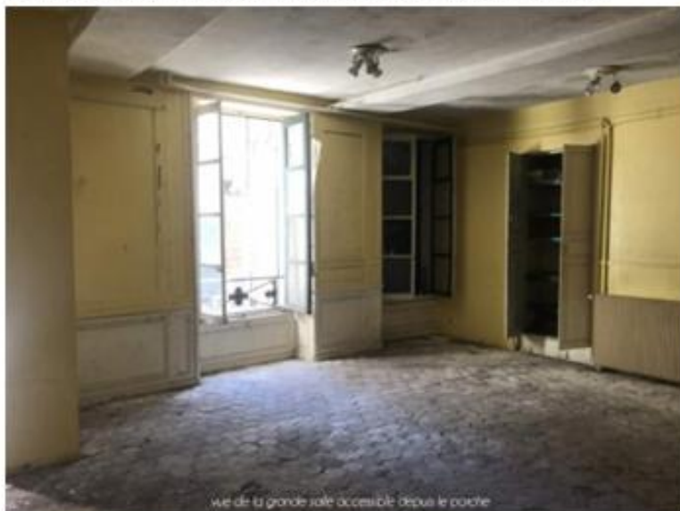
vue de la grande salle accessible depuis le porche
